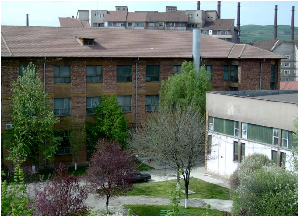
Corpul B și Sala de Sport (Corp E)
